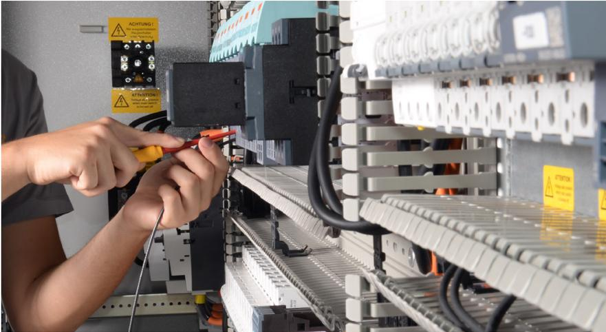
HELDELE Automation umfassende E/A-Checks sowie Messungen für Profinet, Profibus und DGVV V3 durch. Die Ergebnisse wurden normgerecht dokumentiert, um höchste Qualitätsstandards und Sicherheitsanforderungen zu erfüllen.
